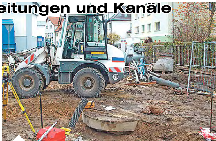
Bei den Bauarbeiten in der Gerber-, Heinrich- und Lustgartenstraße wurden u. a. neue Trinkwasserleitungen verlegt.
